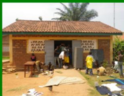
Bâtiment à transformer en dortoir provisoire
